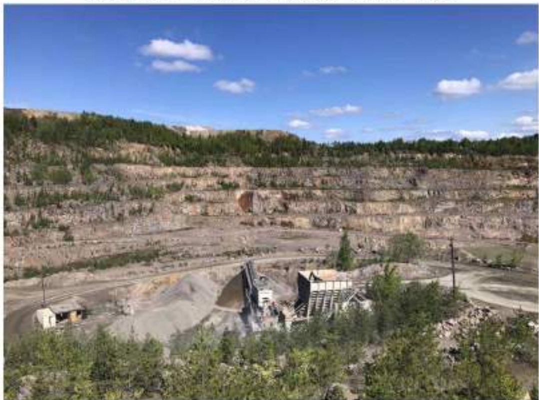
Рис. 1.15 – Загальний вигляд території кар'єру, в межах якої проводили дослідження
